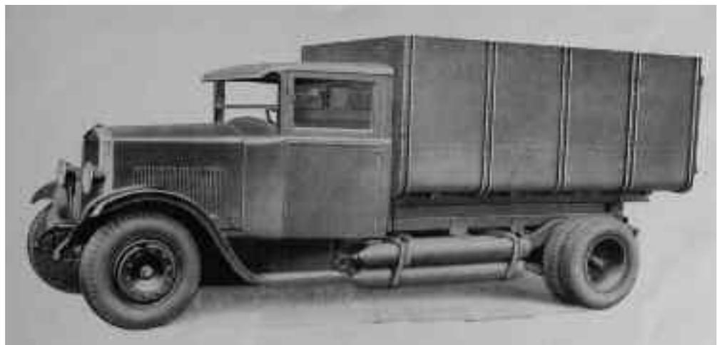
*Véhicule Rochet-Schneider alimenté au gaz de ville
