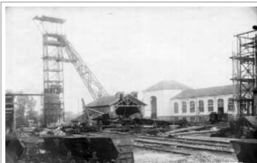
Etablissement des mines de Droitaumont : construction du puit n° 1. Etat d'avancement des travaux au 21 juillet 1909. Collection Académie François Bourdon - Le Creusot.
